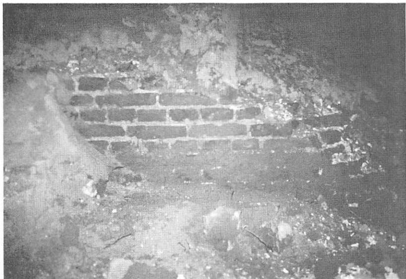
Een deel van de funderingsrest in de sleuf was nog circa 50-60 cm hoog.
