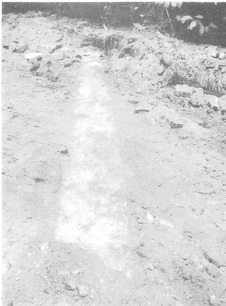
Detailopname van de fundering (foto: H. Simons).
