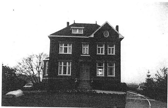
Het woonhuis van de familie Janssen uit 1926 voor de verbouwing van 1980. In de noordgevel is de eerste steen uit dat jaar (gelegd door Rosalie Janssen) nog aanwezig.
