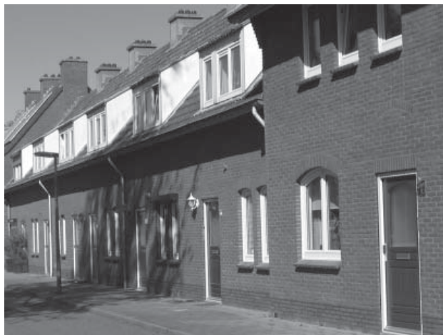
De eerste woningwetwoningen gebouwd in Swalmen, mooi opgeknapt - anno 2019
