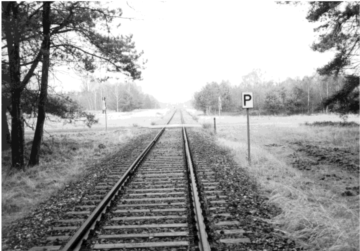
Abbildung 5 Der Kleinbahnbetreiberin in Frankfurt gehörendes Teilstück ab Prellbock an der Straße „E“ mit Blickrichtung Nordnordosten Richtung Bahnhof I. Aufnahme vom Januar 2000. Bildquelle: A. Strehlke (audy13.bmp)
