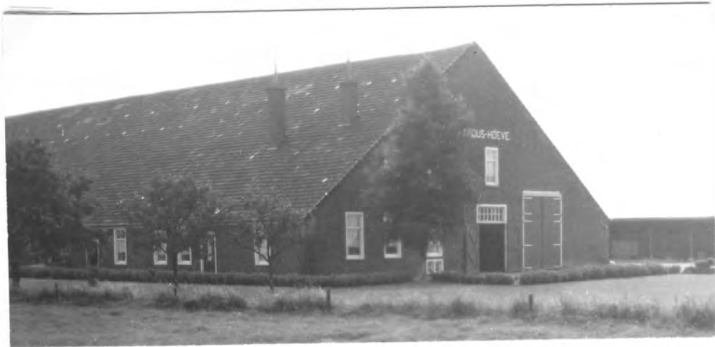
Schuur en woning parallel onder een dak. Een combinatie van alle soorten boerderijen.
