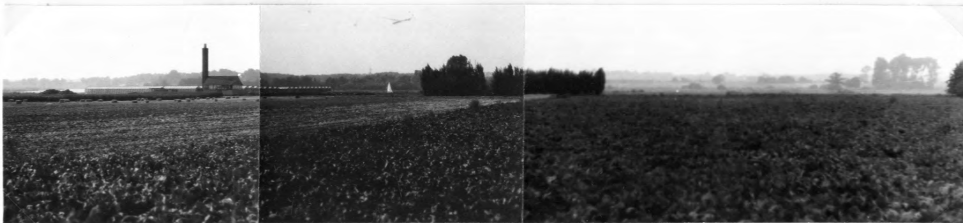
Kascomplexen in het smalle terassengebied van de Maas. Het complex is hier wel zeer ongelukkig gesitueerd, omdat het uitzicht volledig wordt weggenomen. Ook dient men met een niet transparante beplanting voorzichtig te zijn in dit kwetsbaar gebied.
