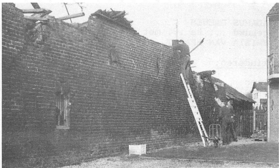
* Werknemers van een Venlose bouwfirma bezig met de sloop van de noordelijke zijgevel. De stenen werden gebruikt voor de restauratie van de watermolen te Grubbenvorst.
