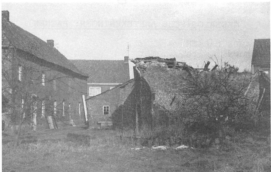
* Links het woonhuis en rechts de ingestorte schuur.
